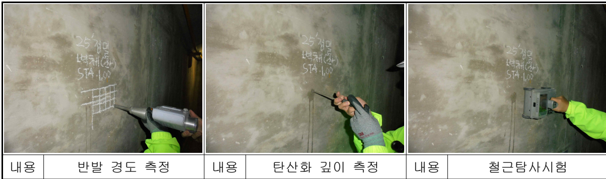
【사진 4.4】 송포일산인출 전력구 재료시험 전경
